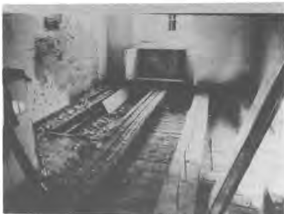
Instandsetzung der Holzbalkendecken in der Jagowstr. 12
