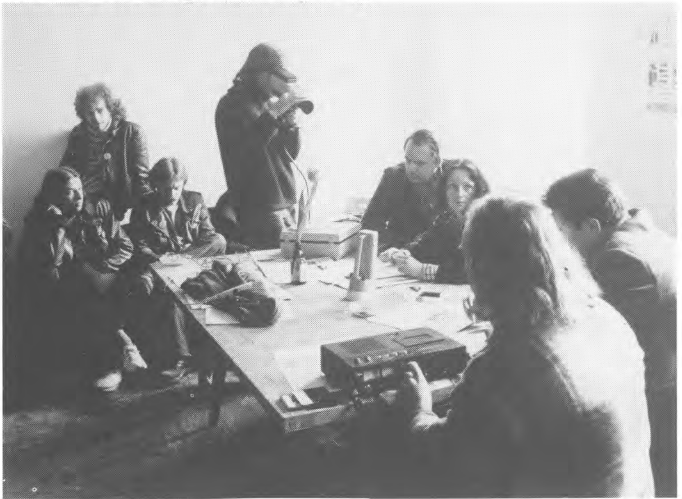
Pressekonferenz, eine Instandbesetzung in der Görlitzerstr. 74
